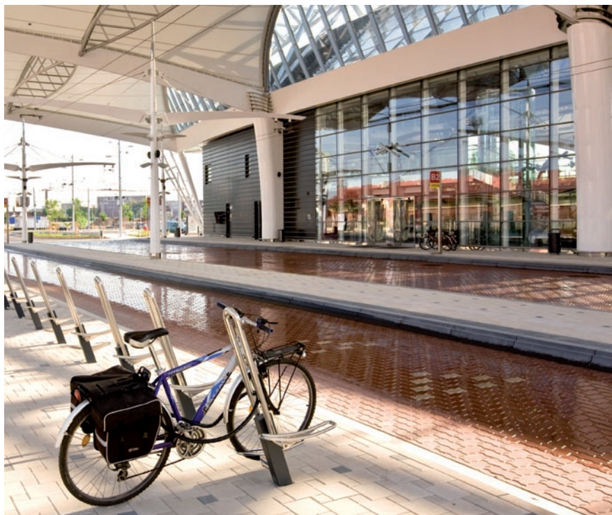
Prostor pod membránami po dokončení
