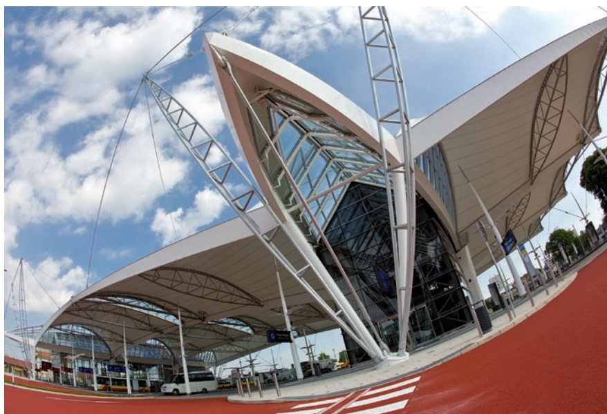
Konstrukce je dokončena. Zakřivení je záměrně zdůrazněno objektivem.
