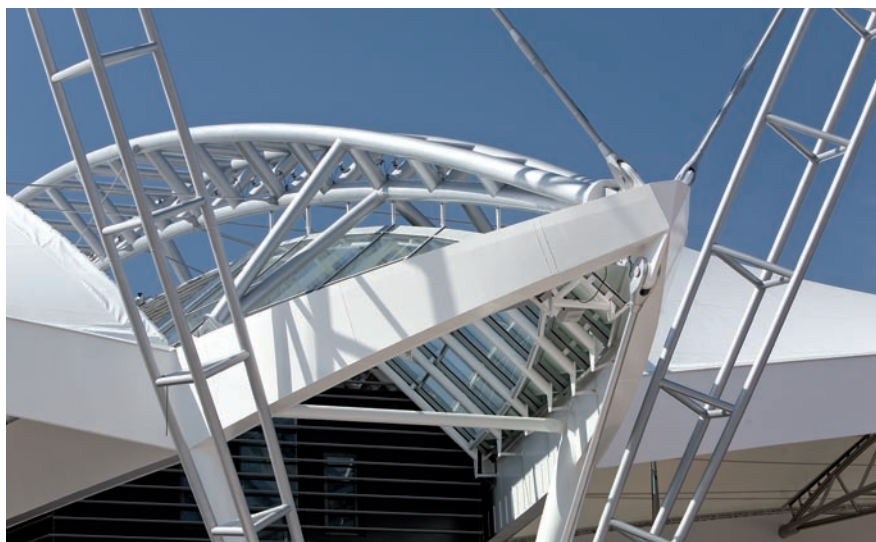
Pohled na zakončení obvodových prstenců a páteřního obloukového nosníku
