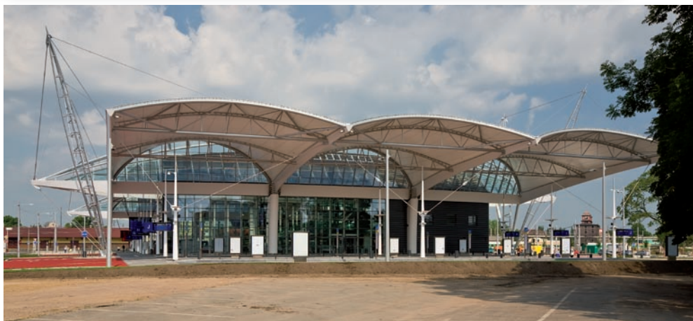
Pohled na konstrukci od JV těsně před přejímkou.
