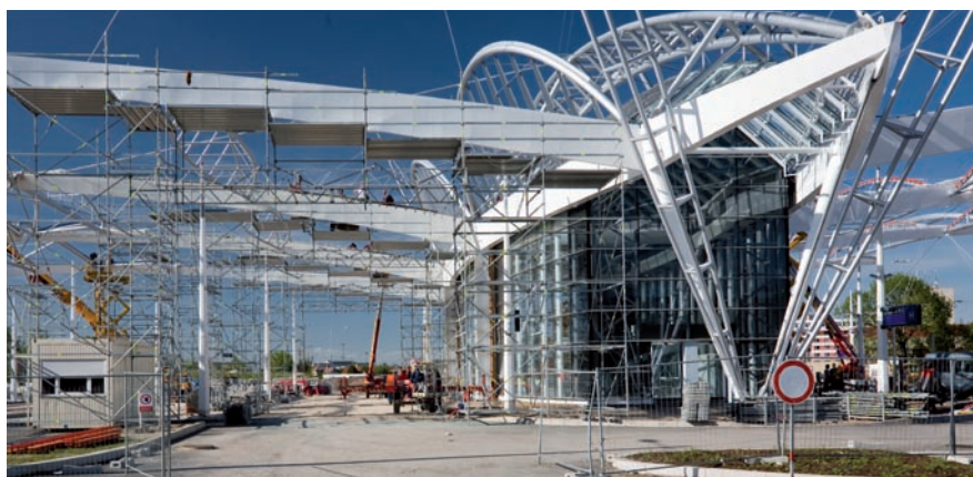
Lešení bylo nutné pro provádění náterů a úchytů pro membrány.
