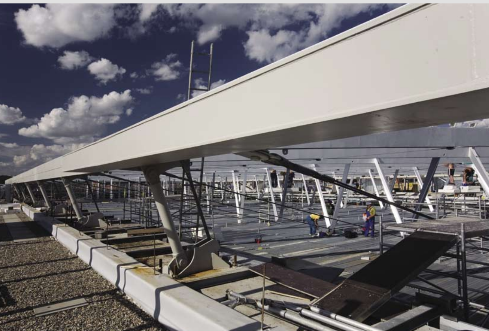
▼ Na obvodovém věnci jsou šikmo uloženy střešní nosníky o rozpětí 35,50 m, podporované příčnými předeprnutými lany
