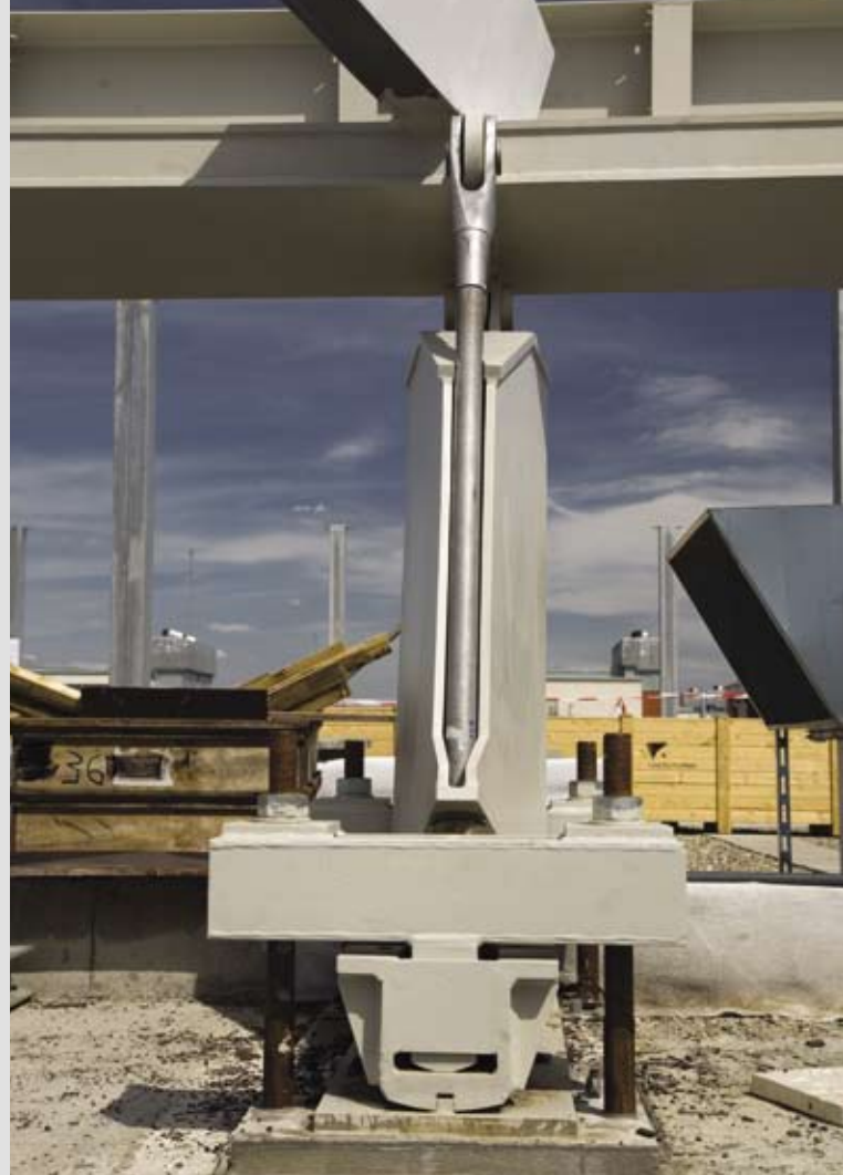
▲ Vetknuté stojky podporující tuhý obvodový věnec
