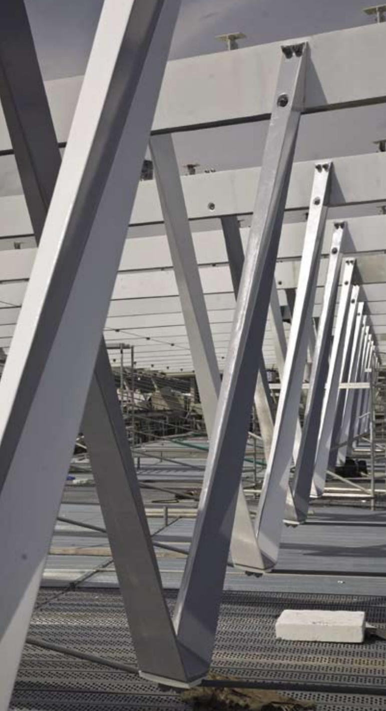
▲ Ocelová konstrukce zastřešení. Rozpěry jsou tvořeny prostorovými vzpěrami velmi specifického, ale na výrobu nenáročného tvaru.
