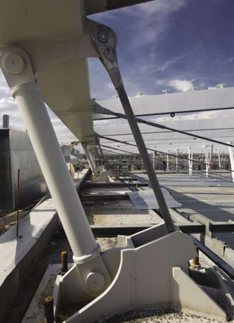
▲ Kynné stojky podporují tuhý obvodový věnec tak, aby nebylo bráněno pohybu konstrukce
