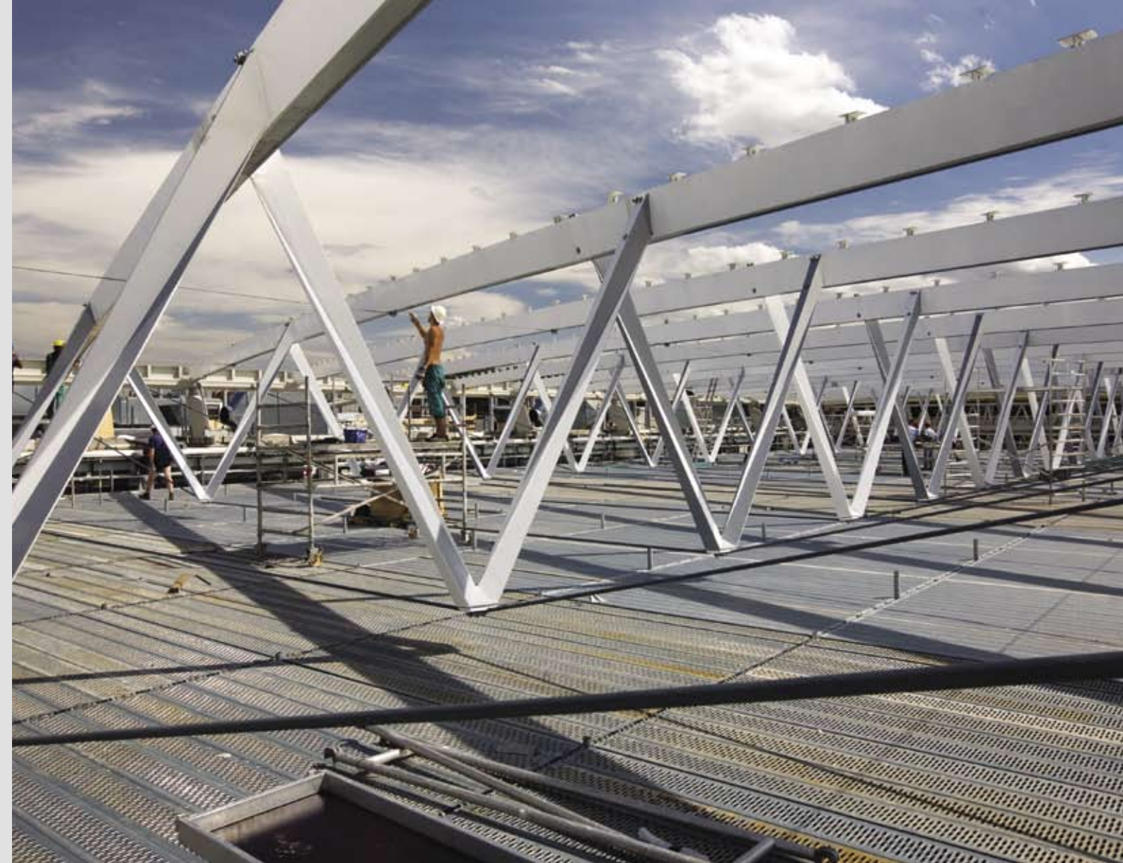
▲ Ocelová konstrukce střechy se skládá z masivního obvodového věnce, střešních nosníků a podpor
