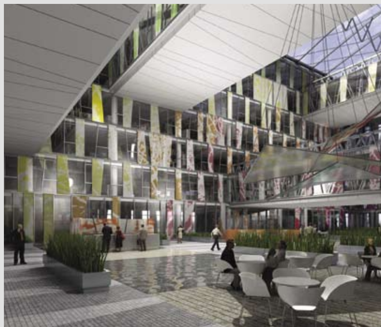
▲ Pohled na vnitřní mostní konstrukce propojující železobetonové objekty stavby v různých výškách a na ocelovou střešní konstrukci, vizualizace
