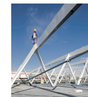
Nadzemní část stavby se skládá ze dvou železobetonových administrativních objektů mezi sebou vzájemně propojených deseti ocelovými mosty, ve kterých jsou také umístěny kanceláře. Vnitřní prostor mezi objekty – atrium – je shora přestřešeno pneumatickými polštáři z ETFE fólie na střešní lanové konstrukci. Z boků je atrium ohrazeno prosklenými zavěšenými štífovými stěnami. Jedná se o velmi komplikovanou prostorovou soustavu stabilizovanou pružinami a předepevnutými lany.
