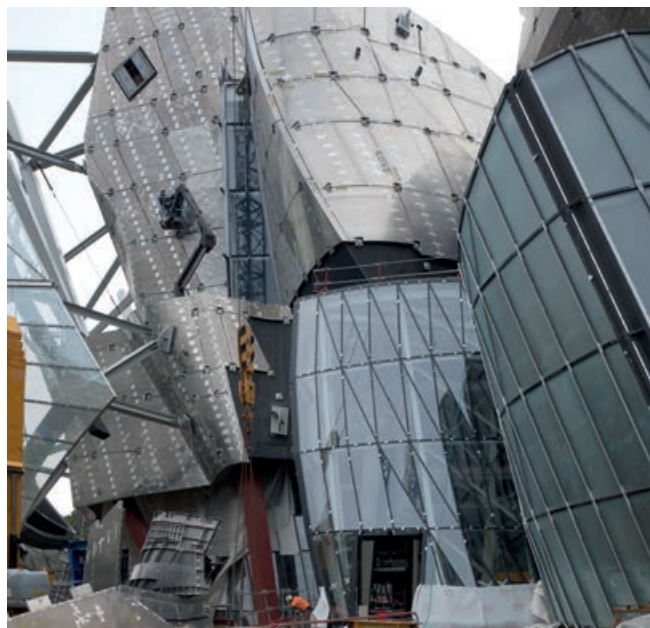
Obr. 3 – Konstrukce při zasklívání
